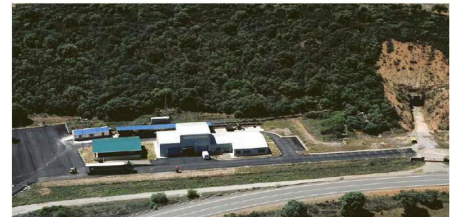
Vista general del Almacén de las Cuevas junto a la mina del mismo nombre.
